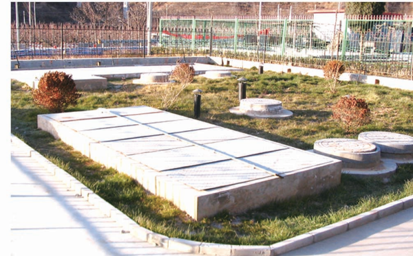
北京平谷区大华山镇泉水峪村污水处理站（钢混地埋式）
