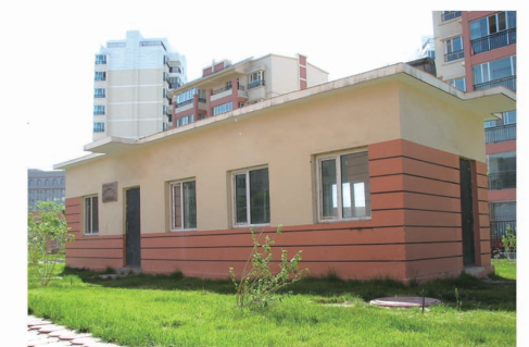
石河子天富巨城小区中水处理站
